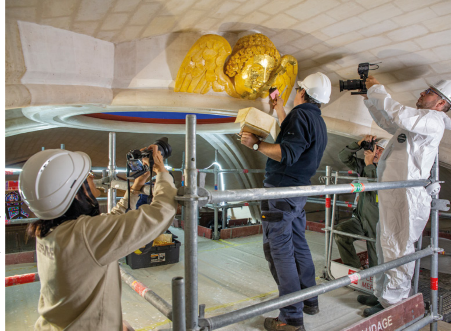
Doreur ornementiste travaillant sur le chantier de restauration de la cathédrale Notre-Dame de Paris. © Olivier Culmann / Tendance floue pour Geste/s magazine
